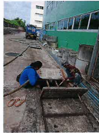
รูปที่ 2-14 กำหนดให้สูบลตะกอนจากถังแยกตะกอน
